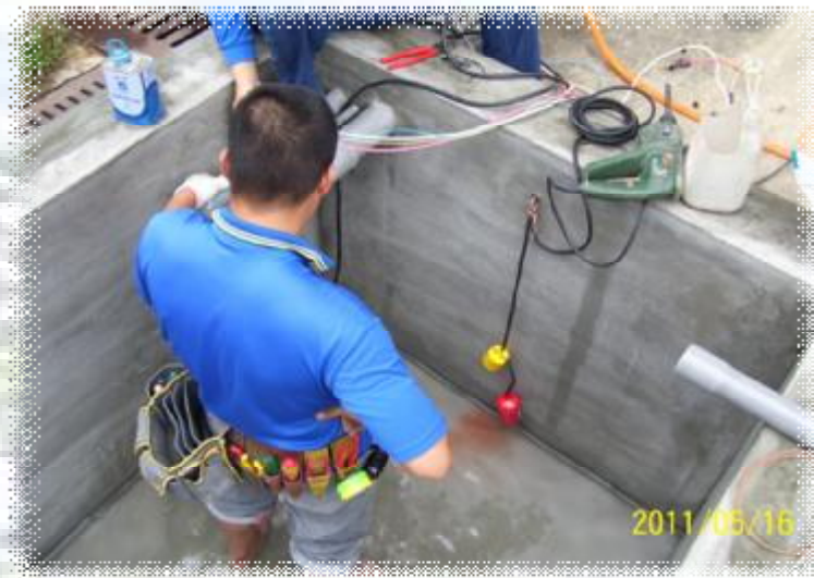
污泥脫水機濾帶清洗改善
