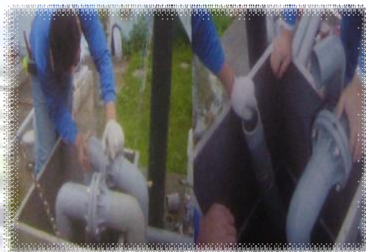
污泥迴流設備維修
